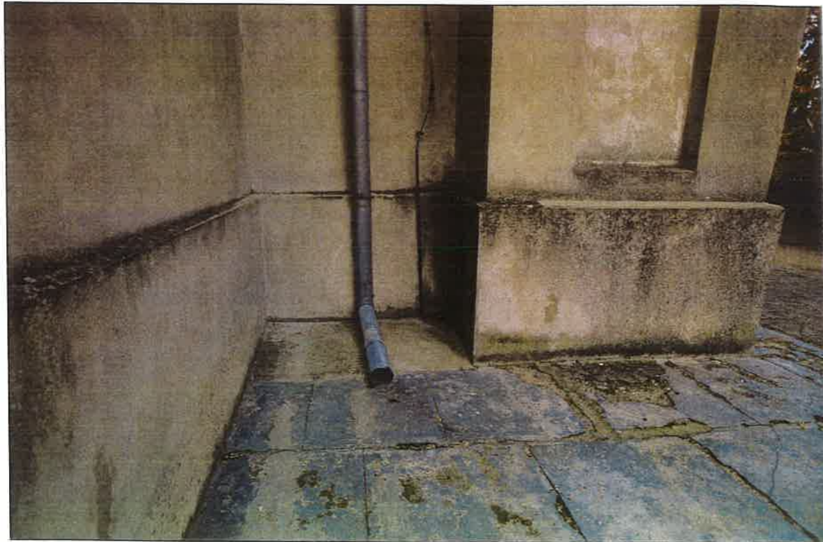
Il. 4. i 5. Pion rynnowy na górnej fotografii wprowadzony do kanalizacji. Na fotografii dolnej pion, z którego woda wylewa się bezpośrednio na chodnik wokół kościoła.
