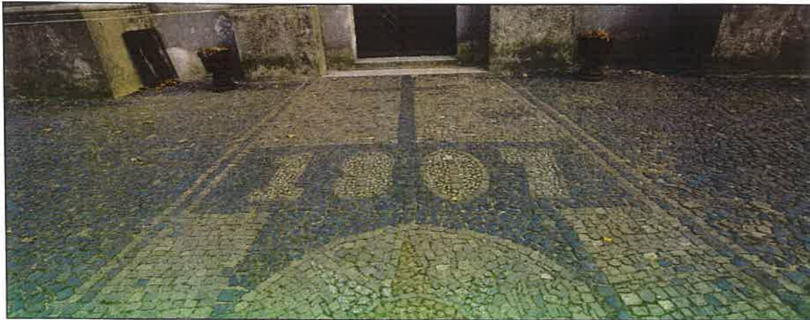
Il. 1. Dekoracyjny układ z wielokolorowej kostki brukowej przed wejściem do kościoła po stronie zachodniej.
