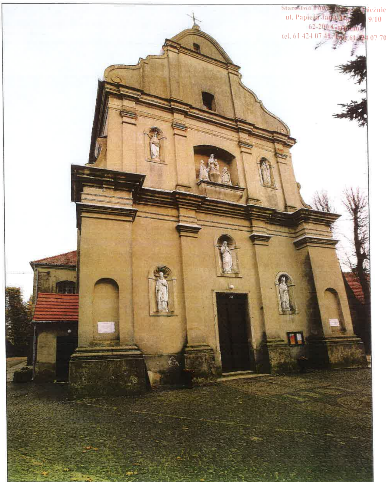
Fot. 2. Widok ogólny elewacji zachodniej od strony północno zachodniej z poziomu placu przed kościołem.
