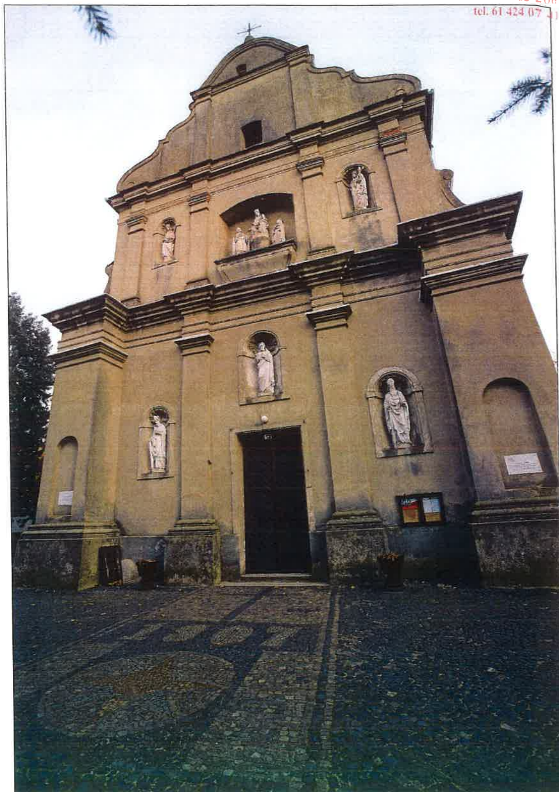
Fot. 1. Widok ogólny elewacji zachodniej z poziomu placu przed kościołem.
