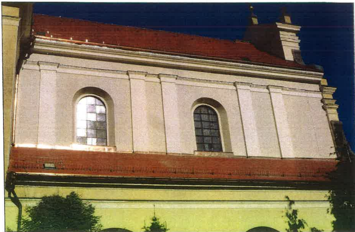
Il. 19. Górne partie elewacji nawy kościoła Karmelitów Bosych w Poznaniu po zakończeniu prac remontowo-konserwatorskich.
