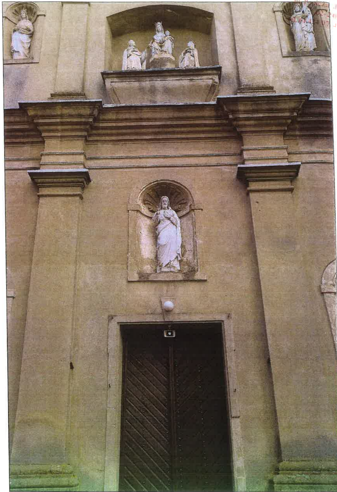
Fot. 7. Wejście główne do kościoła i wnęki z figurami w elewacji zachodniej.
