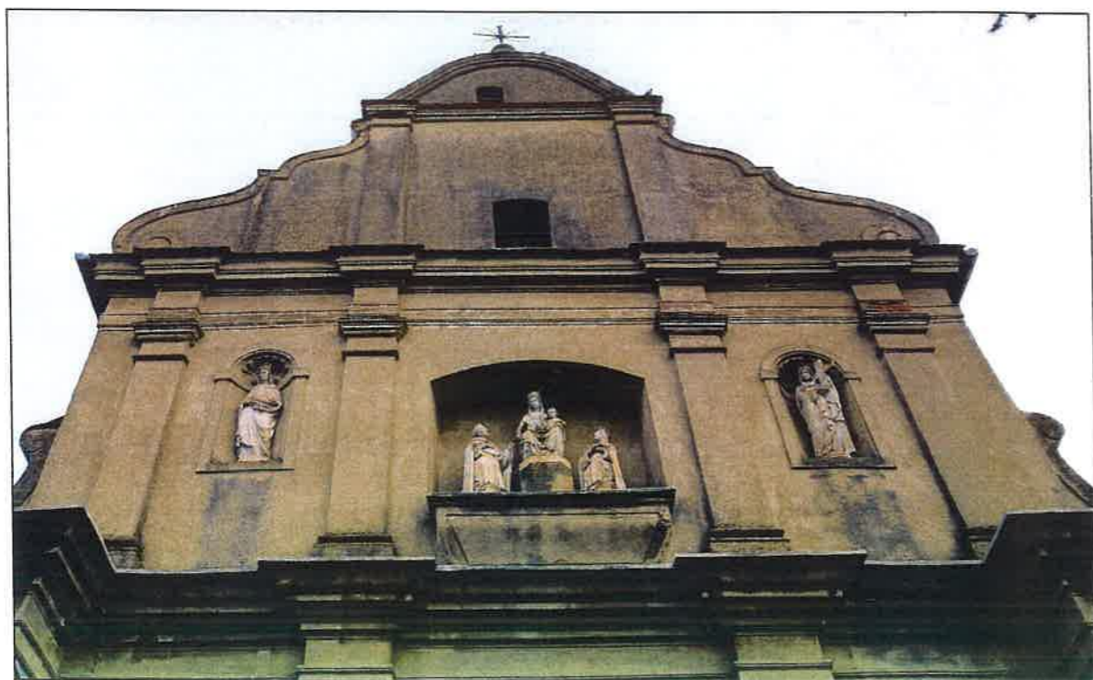
Fot. 10. Wnęki z figurami w partii szczytowej elewacji zachodniej.
